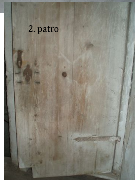
Vstup na půdu – původní dveře
